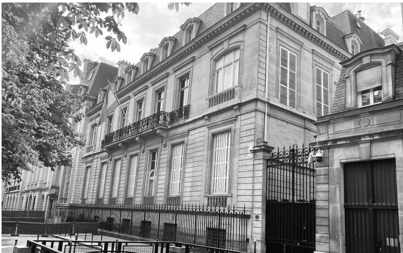
Foto 2. Hotel Wagram, sede del Hospital Franco Uruguayo (Hôpital 52) en París, durante la primera guerra Mundial. Su aspecto exterior prácticamente no se ha modificado. Actualmente funciona una dependencia de la Embajada de España. (Foto del autor)
